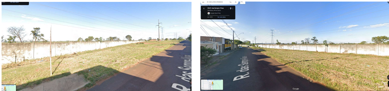
Figura 2 e 3. Diferentes vistas da área. Fonte: Google Street View 2023.
