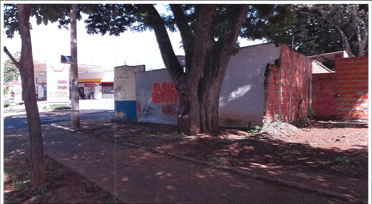
Foto da Área D1 aparentemente com edificação
